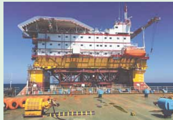
По заказу ЛУКОЙЛа компания «СИ ЭН ЖИ ЭС Инжиниринг» завершает строительство верхнего строения ЛСП и ПЖМ в рамках обустройства месторождения Ракушечное
