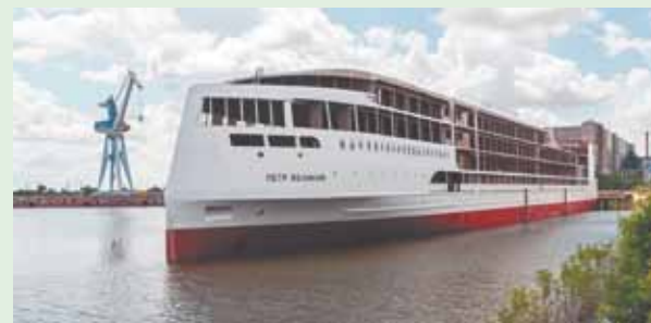
На АО «ССЗ «Лотос» завершается строительство круизного судна проекта RV300
