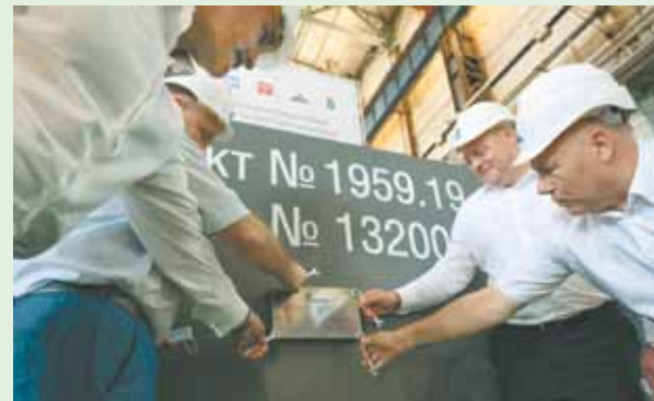
В Астрахани начато строительство модулей платформы ЛСП-А для Каменномысского месторождения
