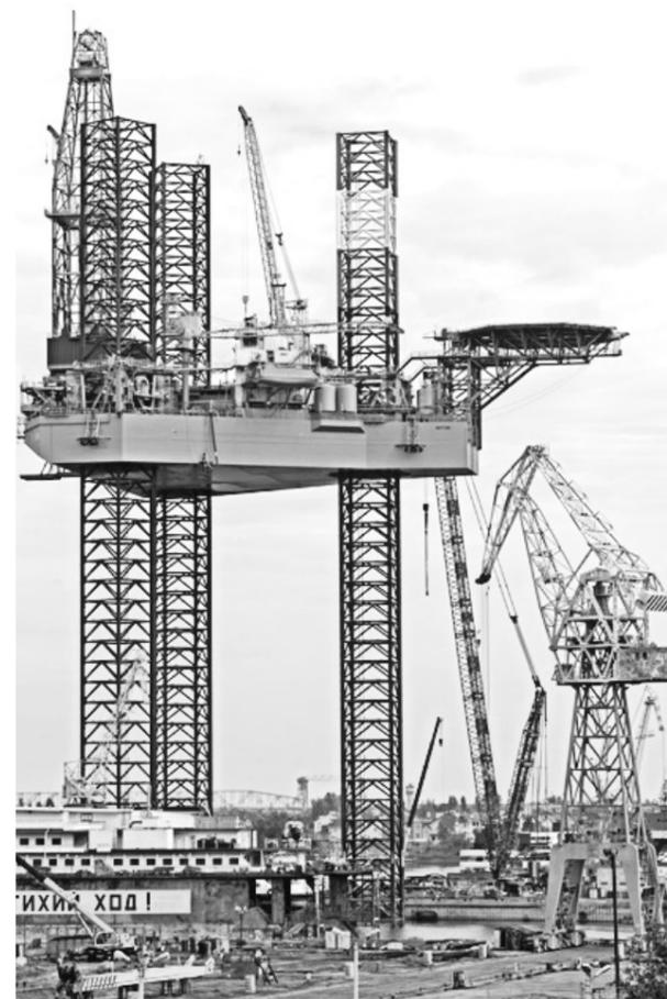
«Каспийская Энергия» в 2013 завершила строительство **самоподъемной буровой установки (проект Super 116E)** для компании **Lamprell Energy Ltd** и приступила к сборке корпуса второй СПБУ.
