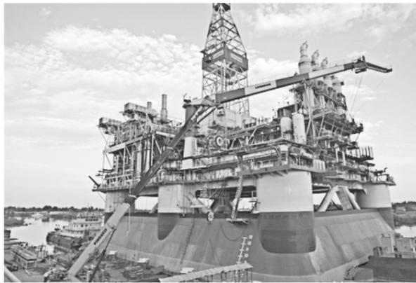
Конструкция морской стационарной платформы «Жданов» состоит из устьевой и жилой платформ, соединенных переходным мостом. Предполагается, что с этой стационарной платформы будет пробурено 8 скважин.
