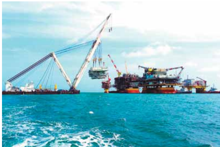
Началась сборка конструкции на верхнем строении платформы в море
